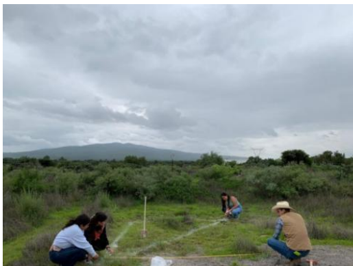
Figura 8. Trazo de puntos auxiliares en terreno (Fuente autoría propia).
