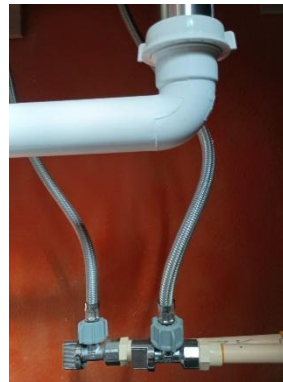
Figura 4. Ejemplo de suministro de agua caliente y fría para conectar el generador termoeléctrico.
