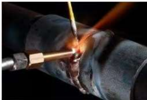
Figura 6. ENSAMBLE: UNIÓN PERMANENTE – Soldadura.
