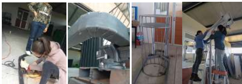
Figura 3. Construcción y ensamble del prototipo Fuente: Elaboración propia
