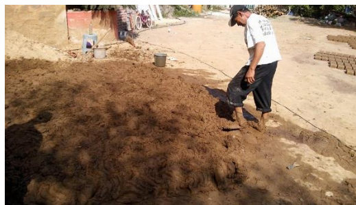
Fig. 2 Mezcla artesanal de materia prima para producción de tabique rojo.
