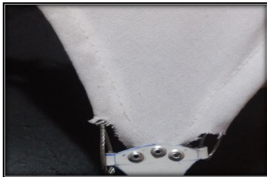
Fig.6 Detalle cable de acero a tensión
