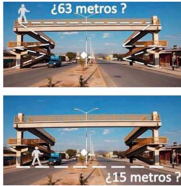
Fig. 4: Comparativa de la distancia de movilidad del peatón entre el puente peatonal y paso a nivel.
